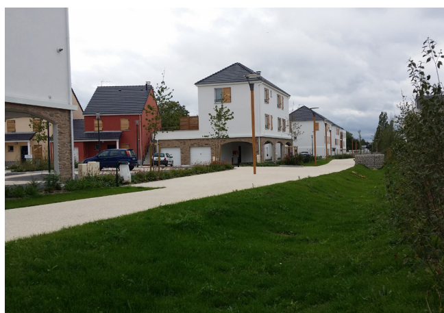
Noue de collecte des eaux au centre du projet
